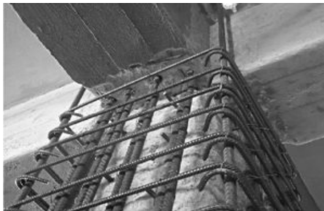
Fig. 11 - Particolare incamiciatura testa pilastro
