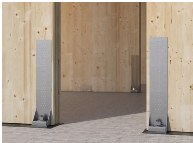
Fig. 2 - Connettori hold-down
